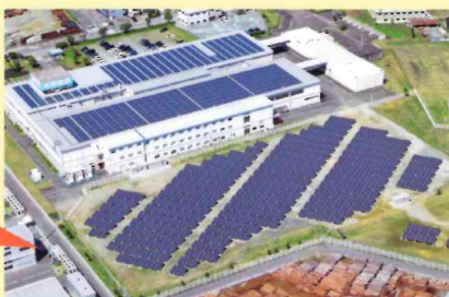
太陽光パネル
